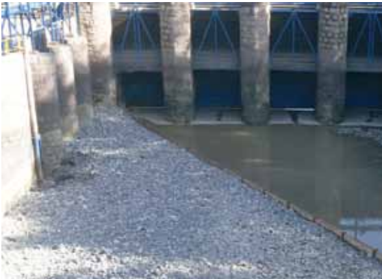
Limpieza bocatoma San Carlos
