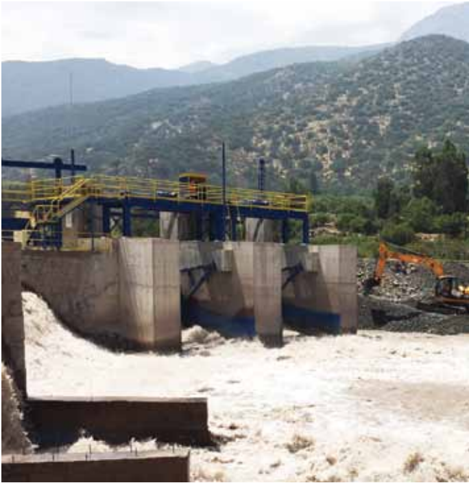
Mantenimiento bocatoma San Carlos
