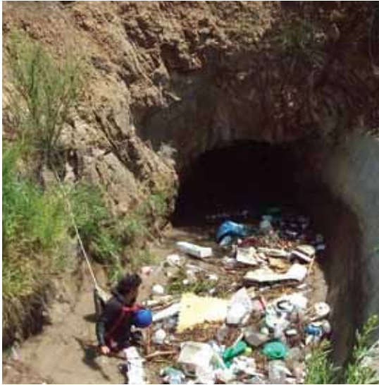
Limpeza túneles Canal El Carmen
