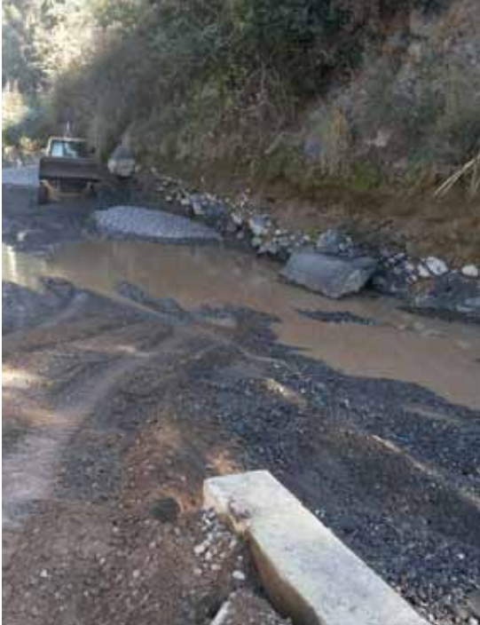
Limpieza San Carlos Tronco
