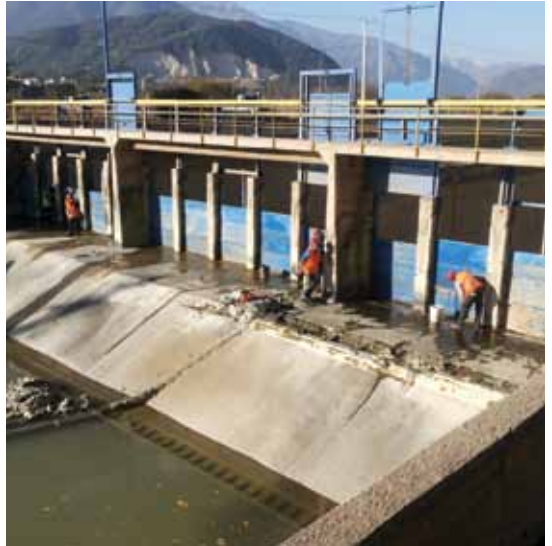
Mantención compuertas desarenador Casas Viejas
