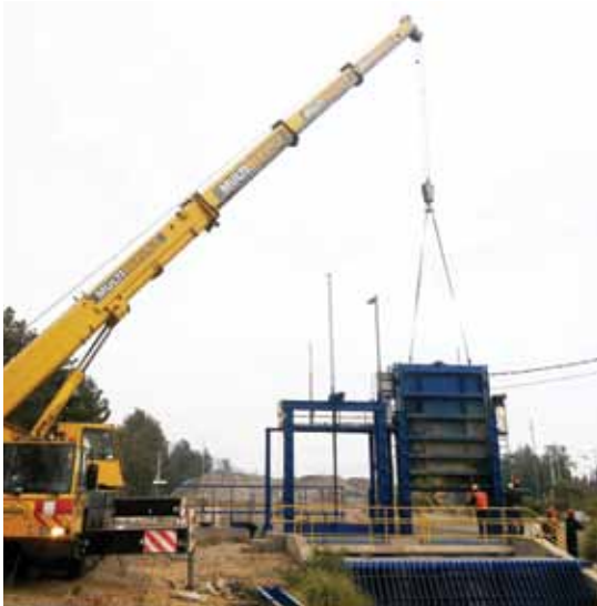
Mantención compuertas Canal Eyzaguirre
