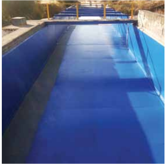
Mantención canoa Canal San Carlos
