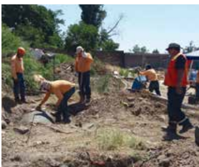
Reparación de tubería en Villa Las Rosas.
