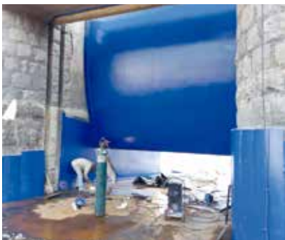
Mantención compuertas radiales Bocatoma San Carlos.
