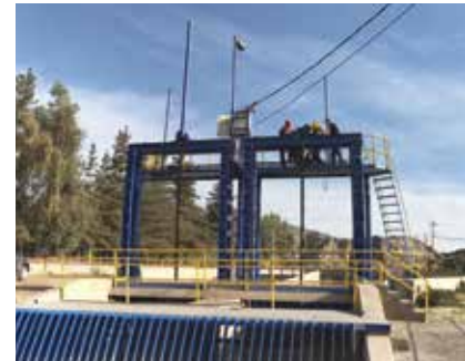
Mantención compuertas del desarenador.
