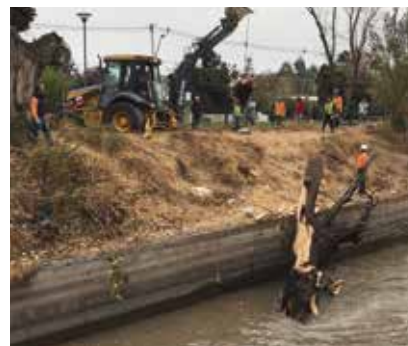
Extracción de árbol en canal San Carlos.
