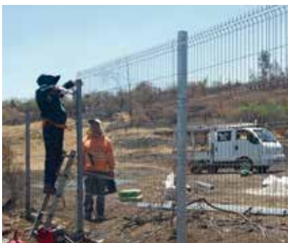
Reparación de cerco en canal Florida.
