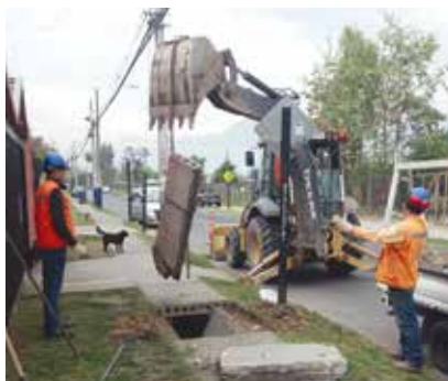
Reemplazo de losetas comunidad Granjas Antiguas.
