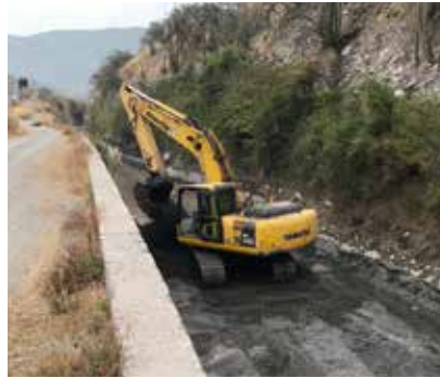
Limpeza canal San Carlos Tronco.
