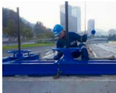
Mantención compuertas canal La Pólvara.
