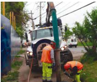
Limpieza tubería canal comunidad Santa Irene de Lo Cañas.
