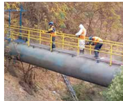
Mantención del cruce Batuco sobre estero Colina.
