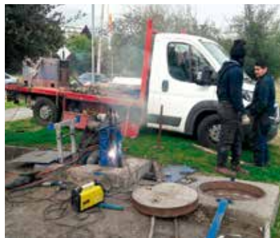
Mantención de compuerta canal Perdices.
