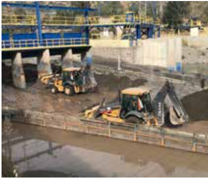
Limpeza Bocatoma San Carlos.
