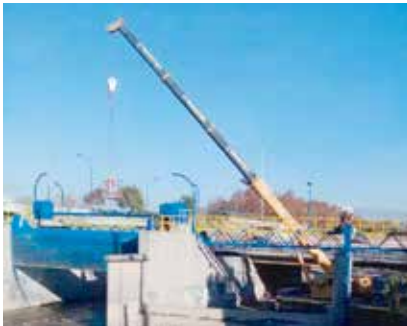
Mantención compuertas Bocatoma La Punta.
